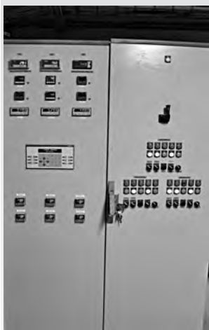
Automate de gestion des pompes de distribution
