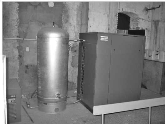
Centrale de production d'air comprimé médical
